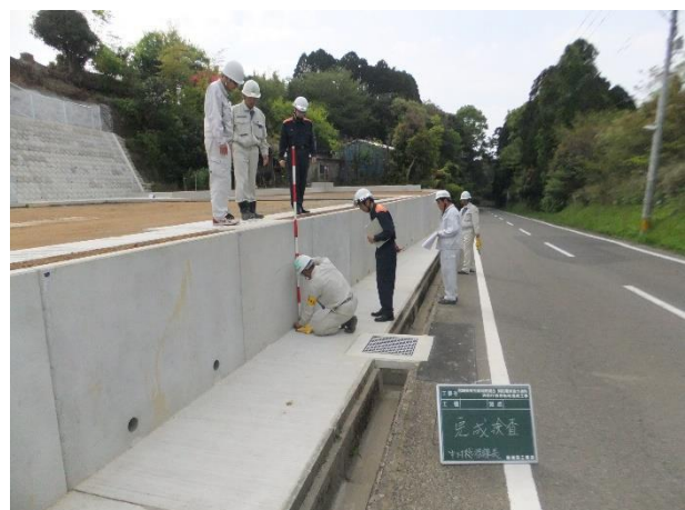
庁舎建設に伴う造成工事完成検査
